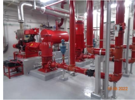
ภาพที่ 2.2-31 ระบบจ่ายน้ำดับเพลิง
