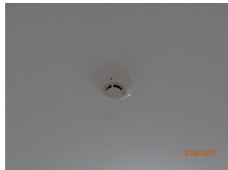
ภาพที่ 2.2-25 เครื่องตรวจจับควัน (Smoke Detector)
