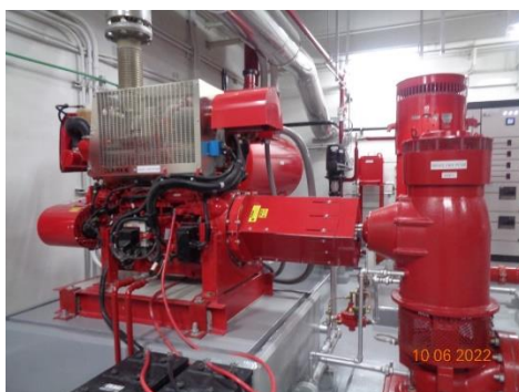
ภาพที่ 2.2-28 เครื่องสูบน้ำดับเพลิงแบบดีเซล
