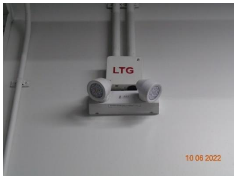
ภาพที่ 2.2-24 ระบบไฟฟ้าฉุกเฉิน
