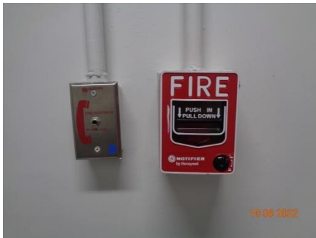
ภาพที่ 2.2-37 อุปกรณ์แจ้งเหตุด้วยมือ (Manual Pull Station)
