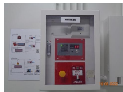
ภาพที่ 2.2-36 แผงควบคุม (FCP)
