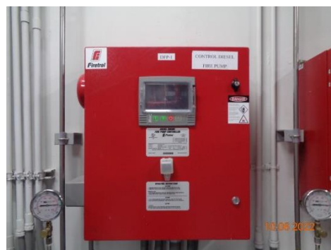
ภาพที่ 2.2-28 เครื่องสูบน้ำดับเพลิงแบบดีเซล
