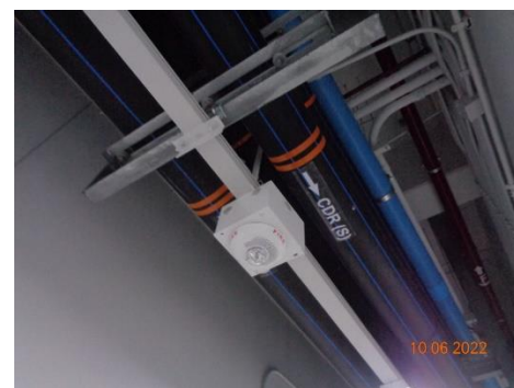
ภาพที่ 2.2-27 เครื่องตรวจจับความร้อน
