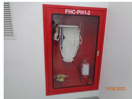
ภาพที่ 2.2-32 ตู้เก็บหัวฉีดน้ำดับเพลิง
