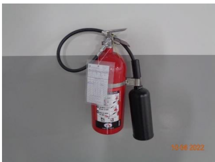
ภาพที่ 2.2-33 ถังดับเพลิงมือถือชนิด CO 2
