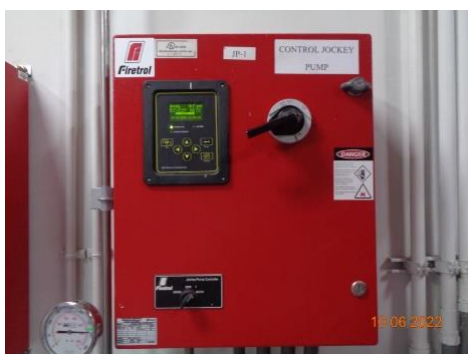
ภาพที่ 2.2-29 เครื่องสูบน้ำดับเพลิงแบบไฟฟ้า
